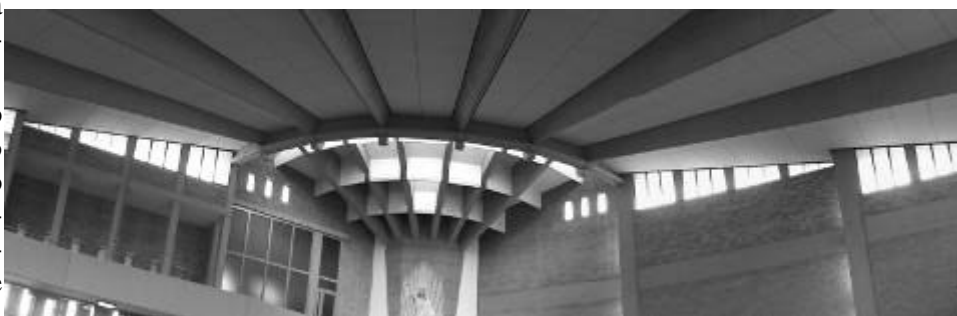
Il nuovo soffitto della nostra Chiesa, insonorizzato per ascoltare meglio la Parola di Dio
